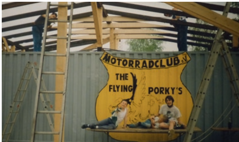
Die Porky's beim Bau ihrer Halle in Wyhlen am Schacht 1994.
